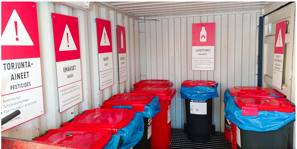
Tervon lajitteluasema vastaanottaa vaarallisia jätteitä.
