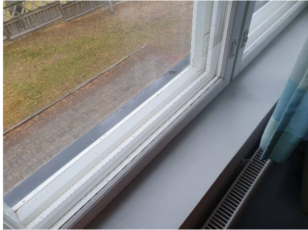
Kirjaston päädyssä yksittäisiä ikkunoita uusittu
