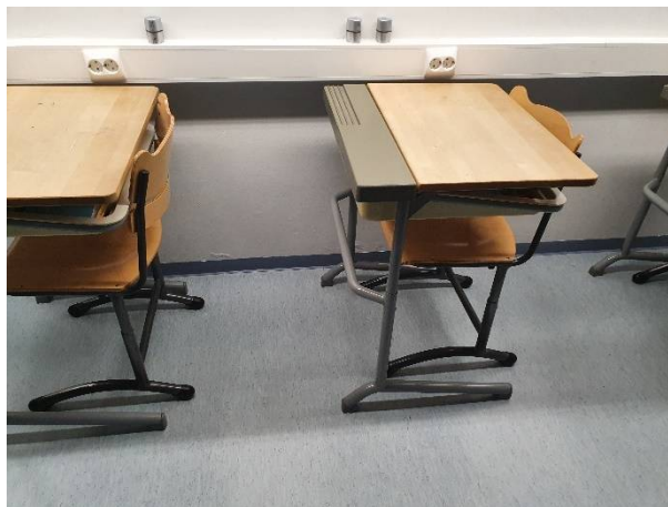
Keittiön vastaisen seinän alaosa maali kupruilee
