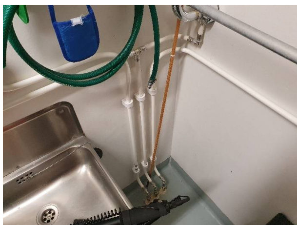
Käyttövesiputket uusittu päärakennuksessa
