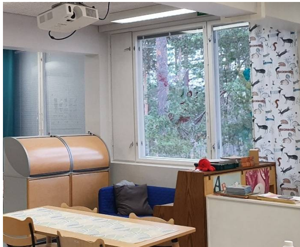
Hätäpoistumisikkunan lasi särkyi, kun ikkunaa Hätäpoistumistien ikkunan ylempi kahva lähes 2,5 metrin korkeudessa
