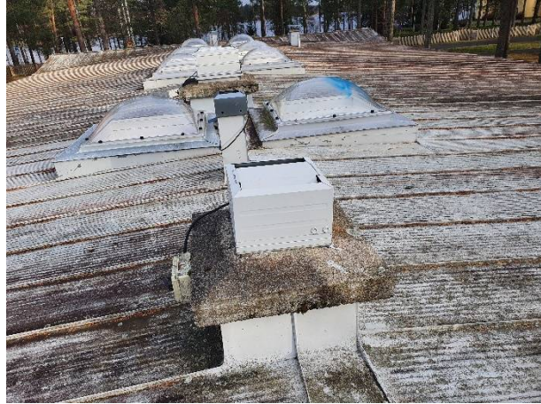
Käsityörakennuksen huippuimureita
