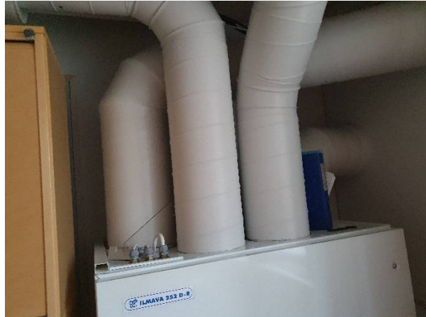
Tulo-poistokoneiden kanavistot kierresaumakanavaa
