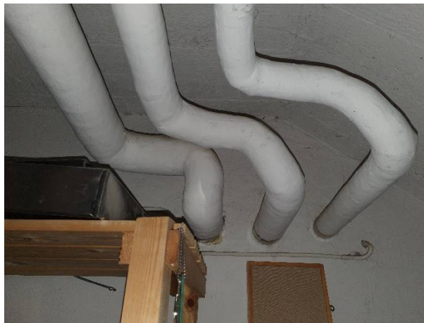
Putkieristeissä asbestia
