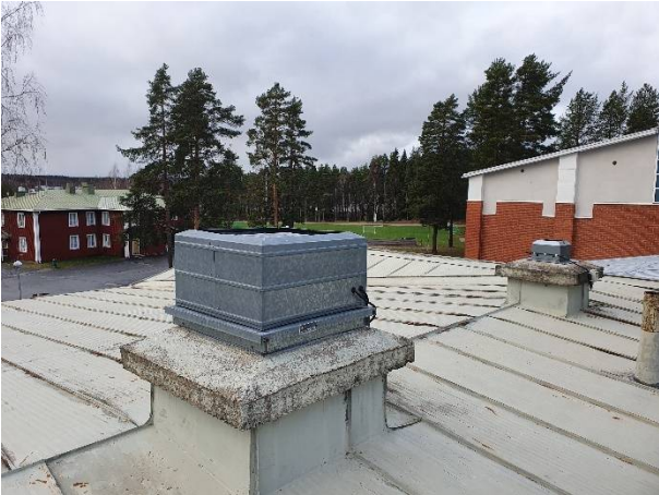
Koneelliset poistot asennettu muurattuihin hormeihin
