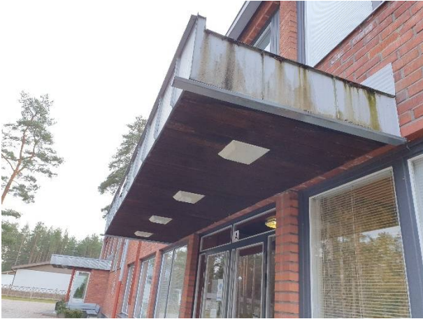
Kattolipalta vedet ohjautuvat maahan
