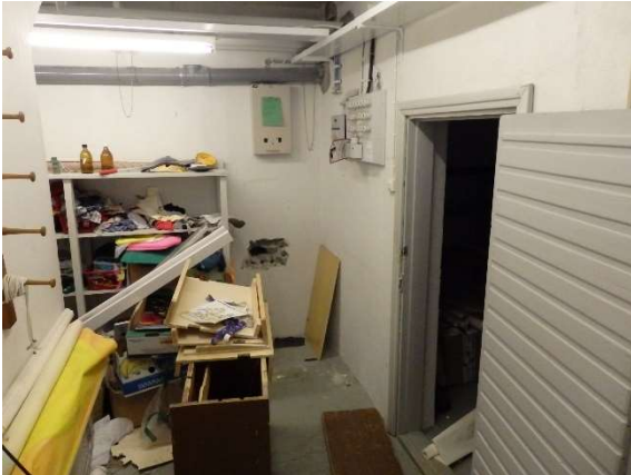
Valmis avaus maanpaineseinässä.
