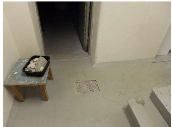
4 kg hyötykäyttökelpoisuus-tutkimus näyte kellarin alapohjasta kattilahuoneen edustalta.
