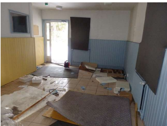
1. kerroksen lattia on auki.
